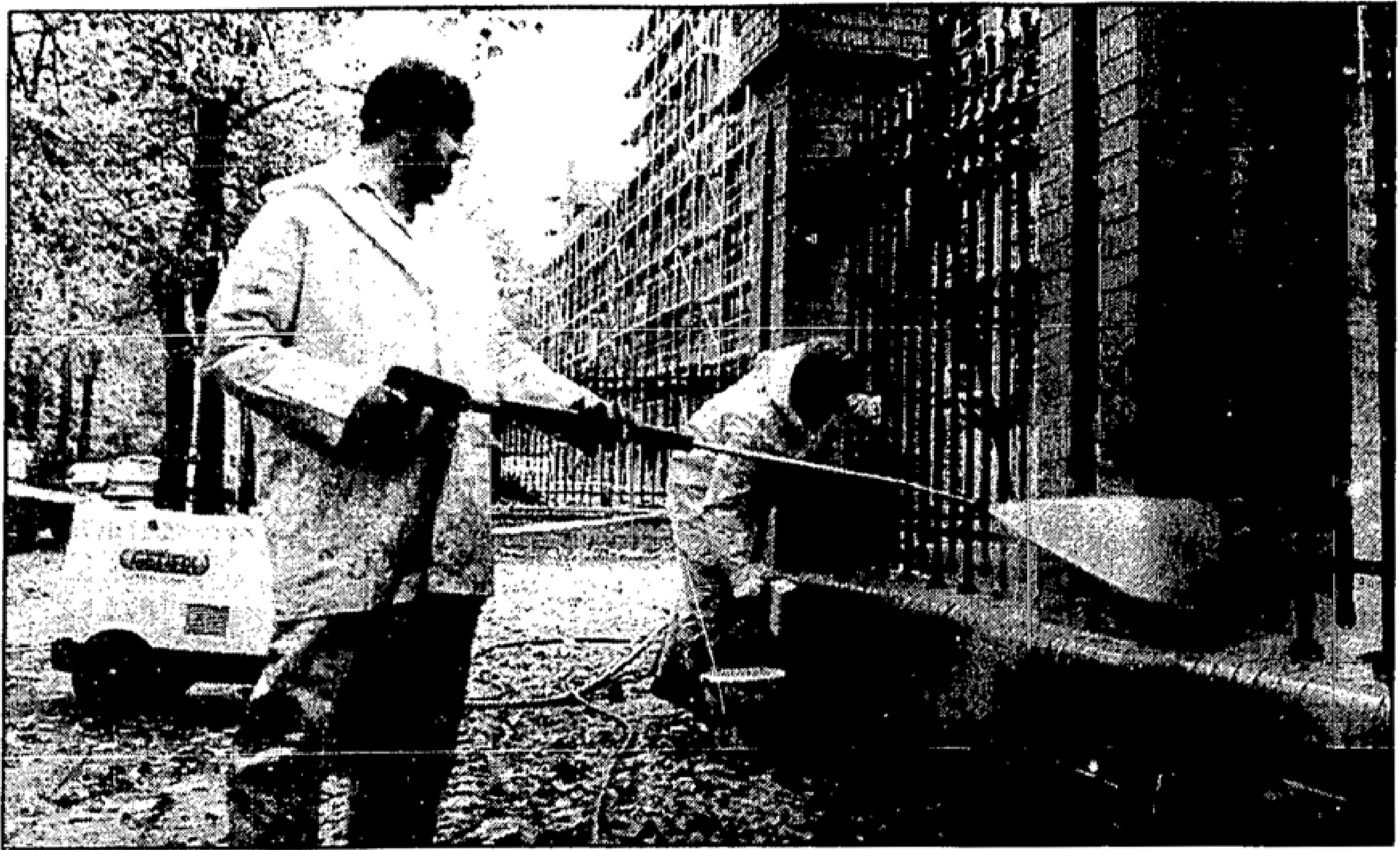
Die Fassadenreinigungsfirma Getifix aus Rauen ist bei der Rekonstruktion der Garnison dabei. Uwe Bernhard (links) und Michael Råde lösen mit heißem Wasserdampf hartnäckigen und alten Schmutz von den Außenmauern. MOZ-Foto: Jur
