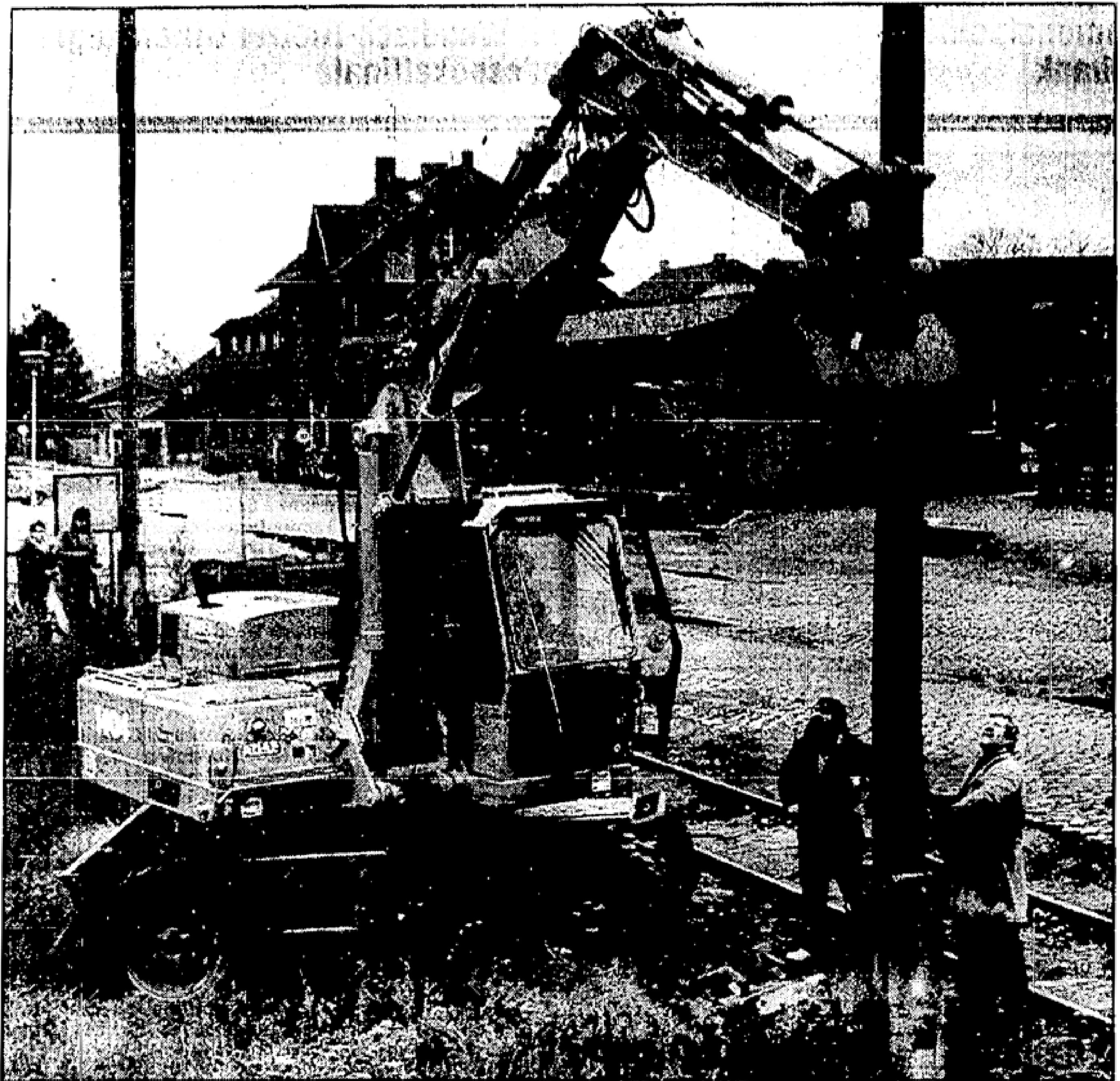
Bevor mit dem Bau eines neuen Busbahnhofes am Beeskower Bahnhof begonnen wird, beräumen Reichsbahner das Gelände. MOZ-Foto: Siegfried Jur
