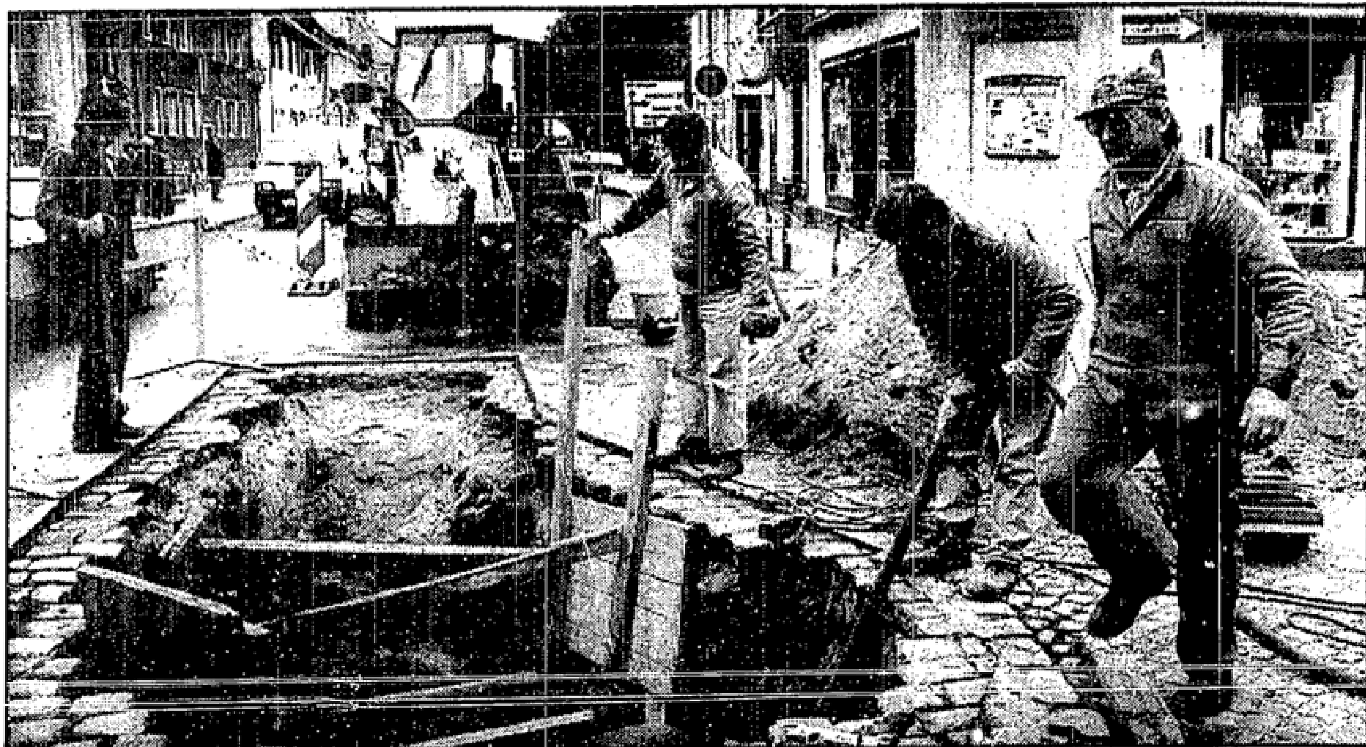
Fiberhaft wird in der Beeskower Innenstadt an der Beseitigung des Rohrbruches gearbeitet.
