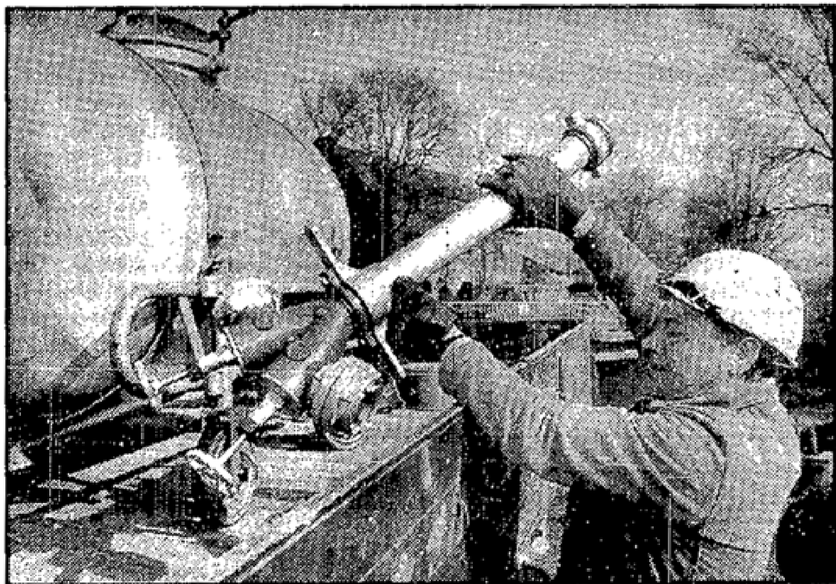
Einer, der an der kleinen Spreebrücke arbeitet, ist Erich Pack.
