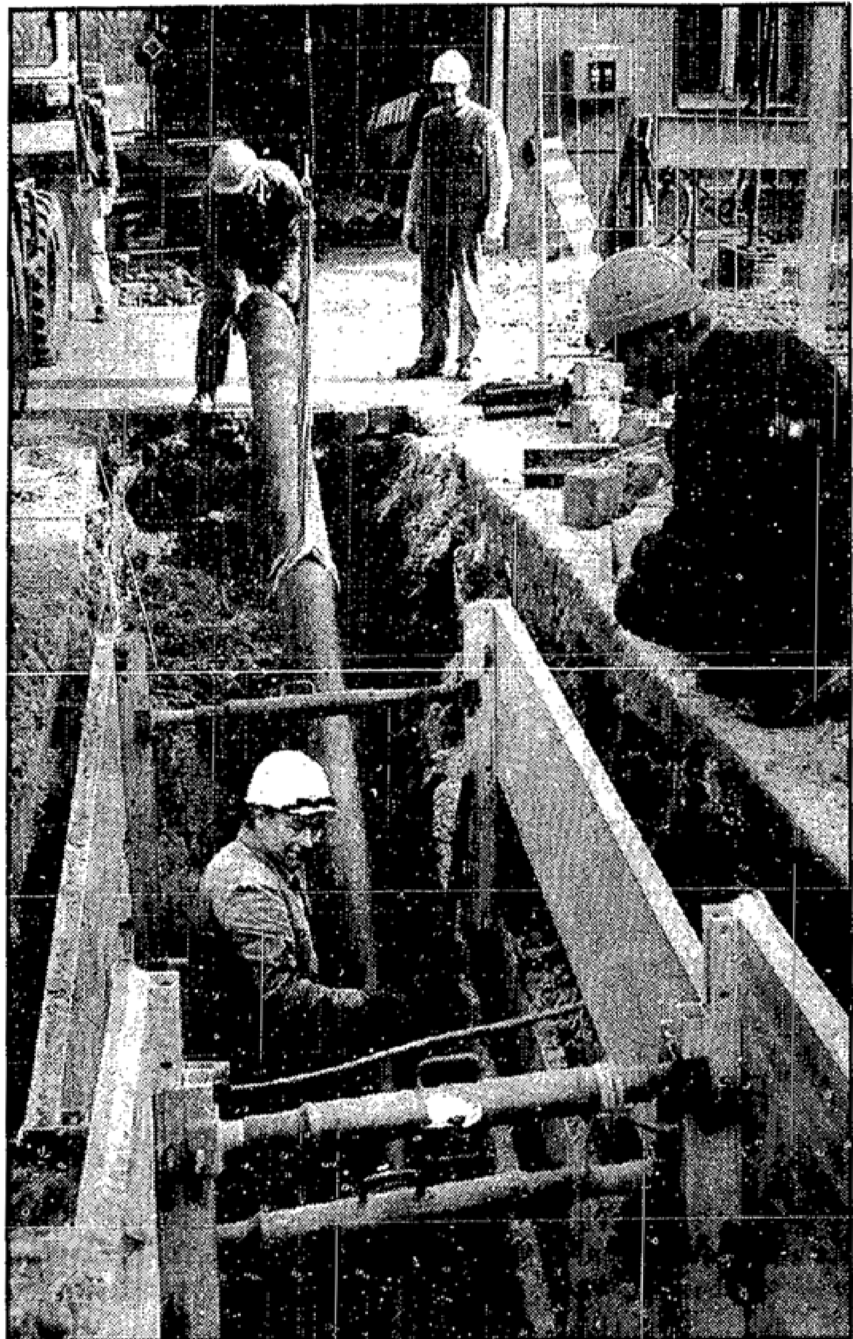
Maßarbeit ist notwendig, um die Abwasserrohre in das vorbereitete Grabensystem einzupassen. Das System soll schließlich viele Jahre funktionieren.
