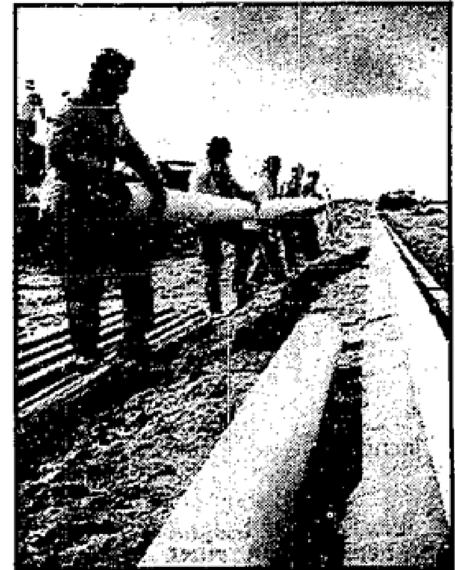
Vorsichtig werden die Rohre abgelegt.
