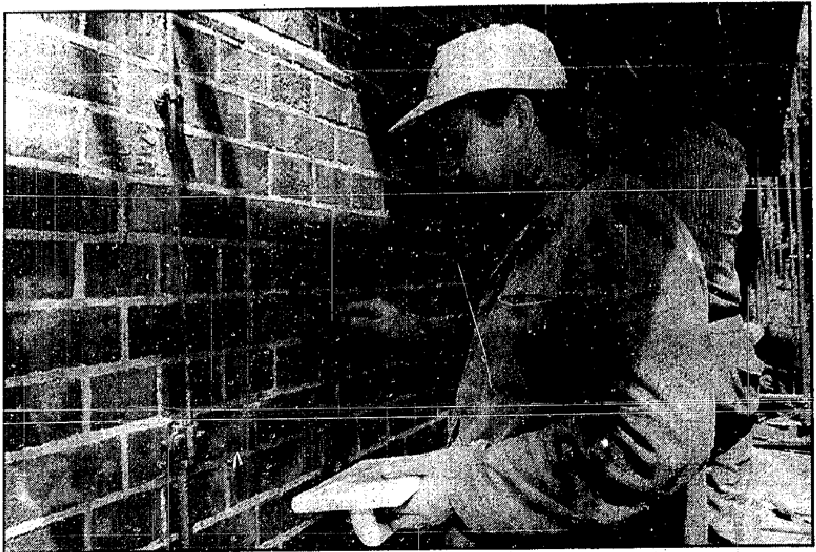
Jozef Janczak und Stefan Tapa bei einer echten Sisyphusarbeit. Sie müssen die rote Fassade des alten Backsteinbaus mit langwieriger Handarbeit wieder herstellen. MOZ-Fotos (2): Jur
