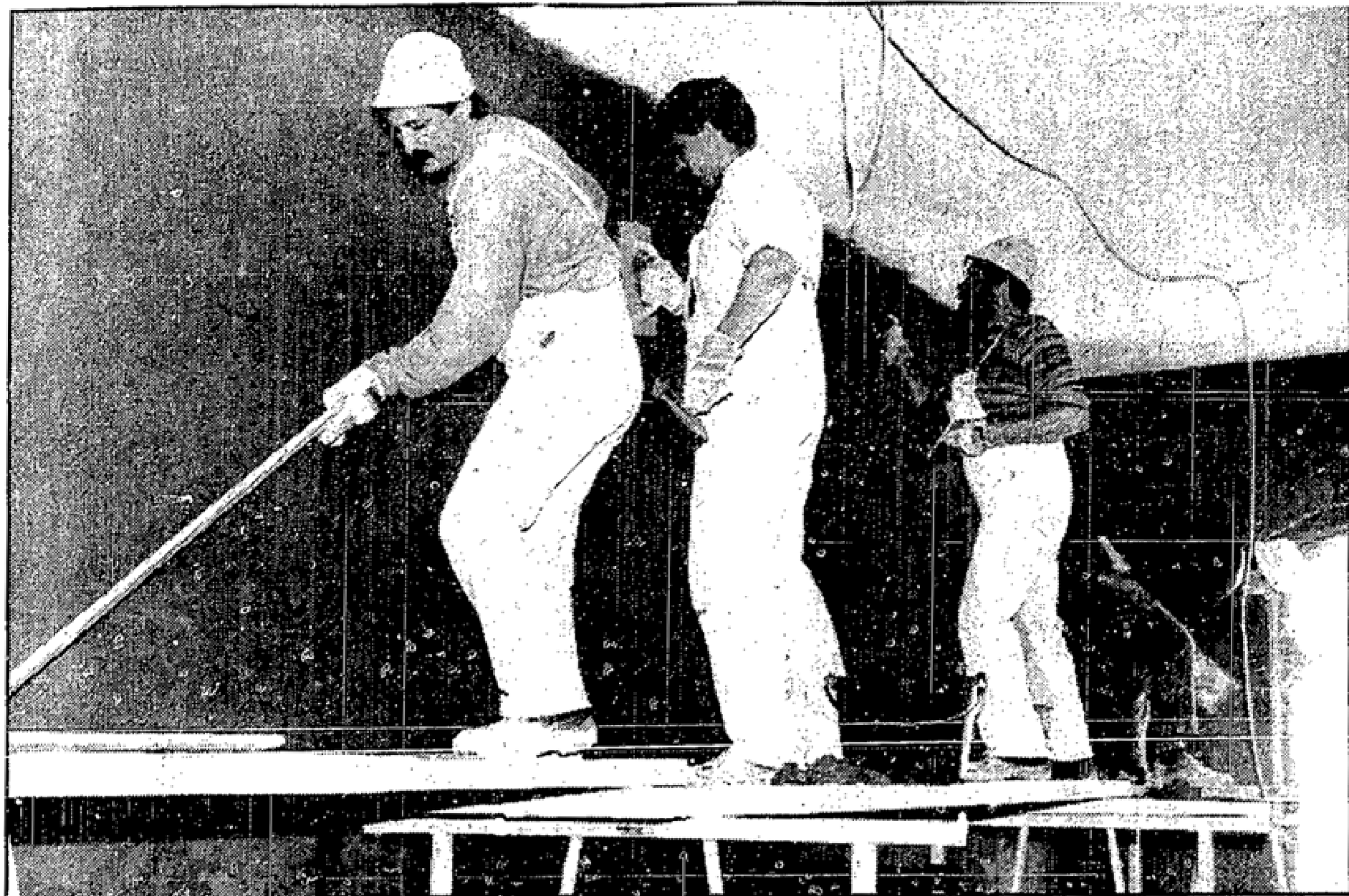
Gegenwärtig laufen die Putzarbeiten im Innern des künftigen Beeskower Gymnasiums. Erdgeschoß und 1. Etage sind schon fertig. MOZ-Fotos: Jur
