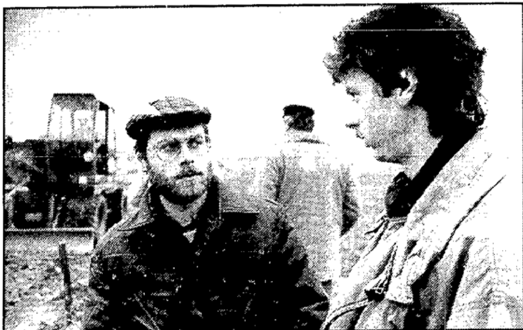
Noch geht man auf dem Gewerbegebiet in die Erde (oben) Kurze Absprache zwischen den Bauleitern Andreas Behlendorf (links) und Lutz Hotzan.
