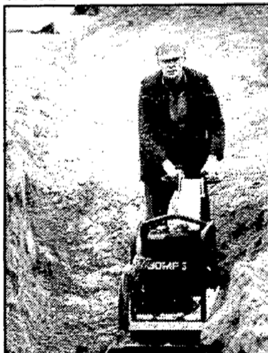
Bevor Rohre verlegt werden, wird der Boden verfestigt. MOZ-Fotos: Jur
