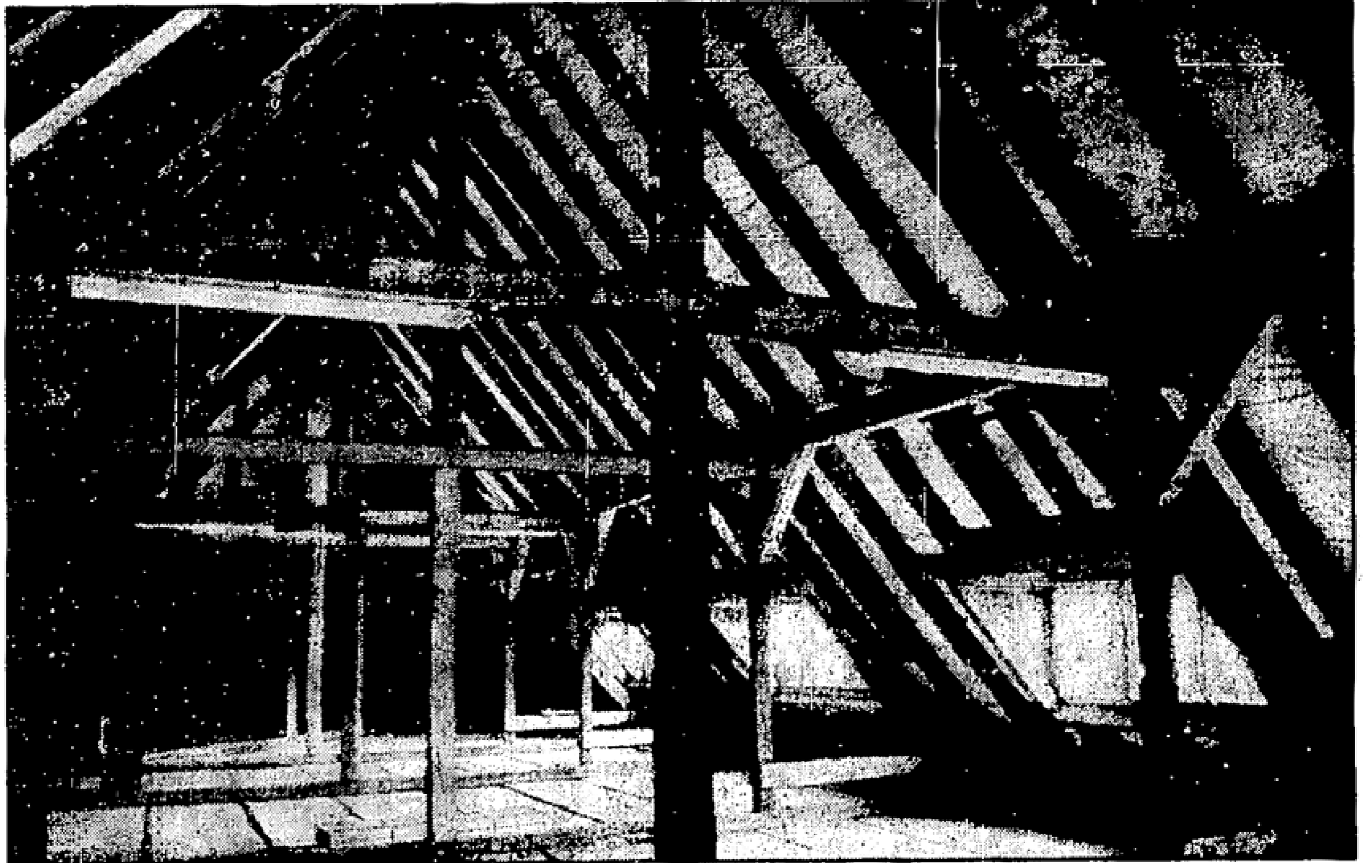
Der Dachstuhl des neuen Gymnasiums warf einige Probleme auf. Die Statik der alten Feldartilleristenkaserne mußte auf die zukünftigen Belastungen ausgerichtet werden, für die Dachdeckung wurden Biberschwanzziegel aus Frankreich benötigt. Auch für die richtige Isolierung gegen Kälte und Wärme mußte Vorsorge getroffen werden.
