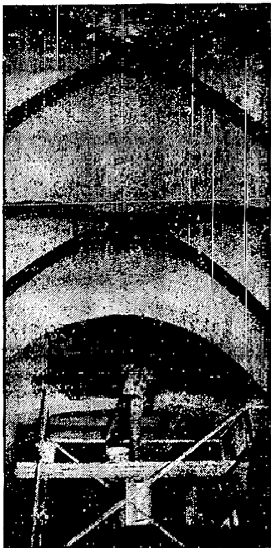
Unter den Händen von Deckenputzer Reinhard Schwarz entsteht das alte Eingangsgewölbe wieder neu.
