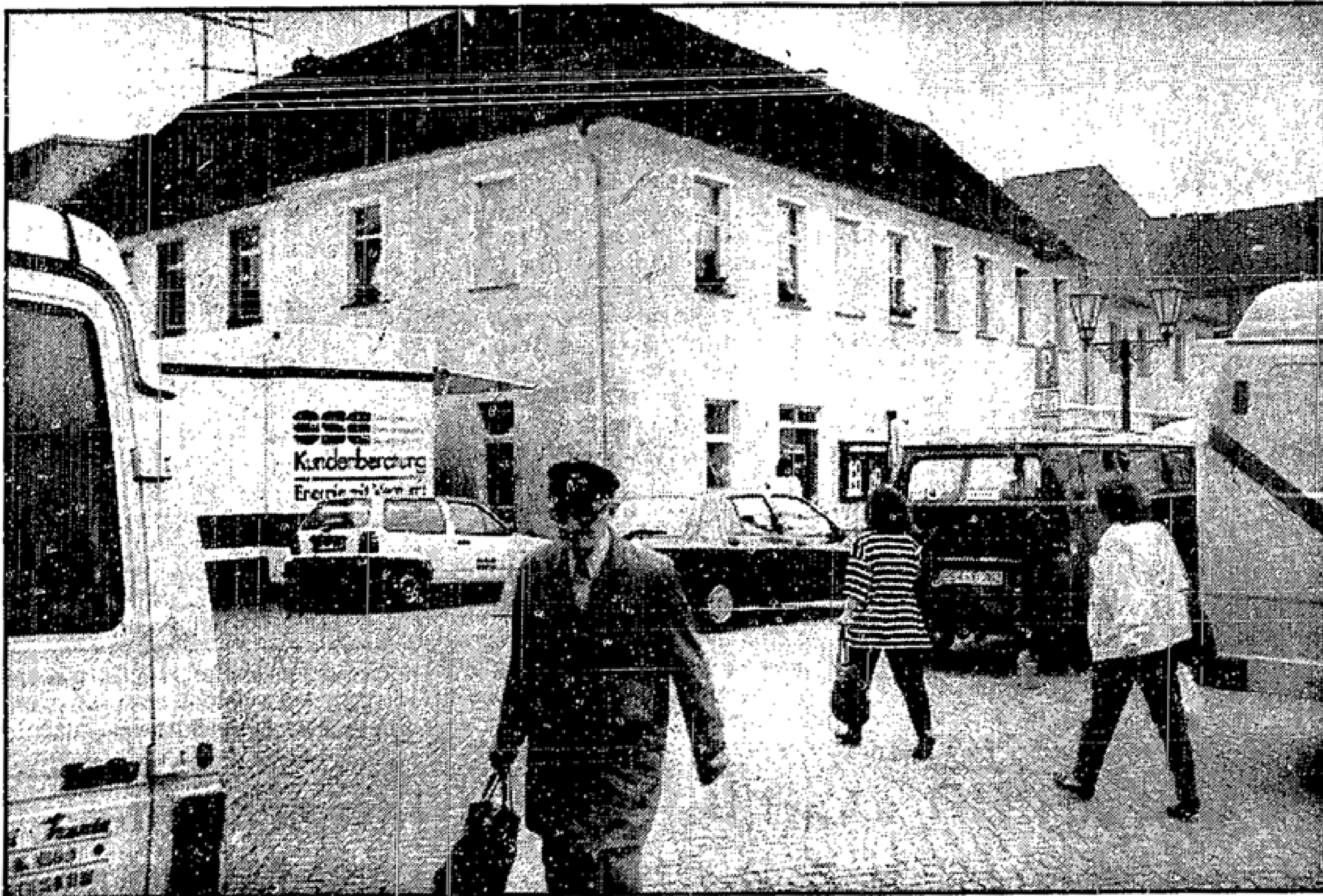
Das Grundstück Markt 1 in der Kreisstadt steht zum Verkauf. Die Stadtväter wollen die Kassen füllen und damit einem Investor die Möglichkeit geben, das denkmalgeschützte Haus zu einem Schmuckstück im Zentrum zu machen. MOZ-Fotos: Jur
