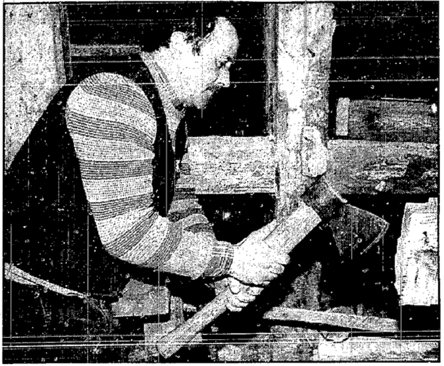
Am Fachwerkgebäude im Innenhof hat im wahrsten Sinne des Wortes der Zahn der Zeit genagt.
