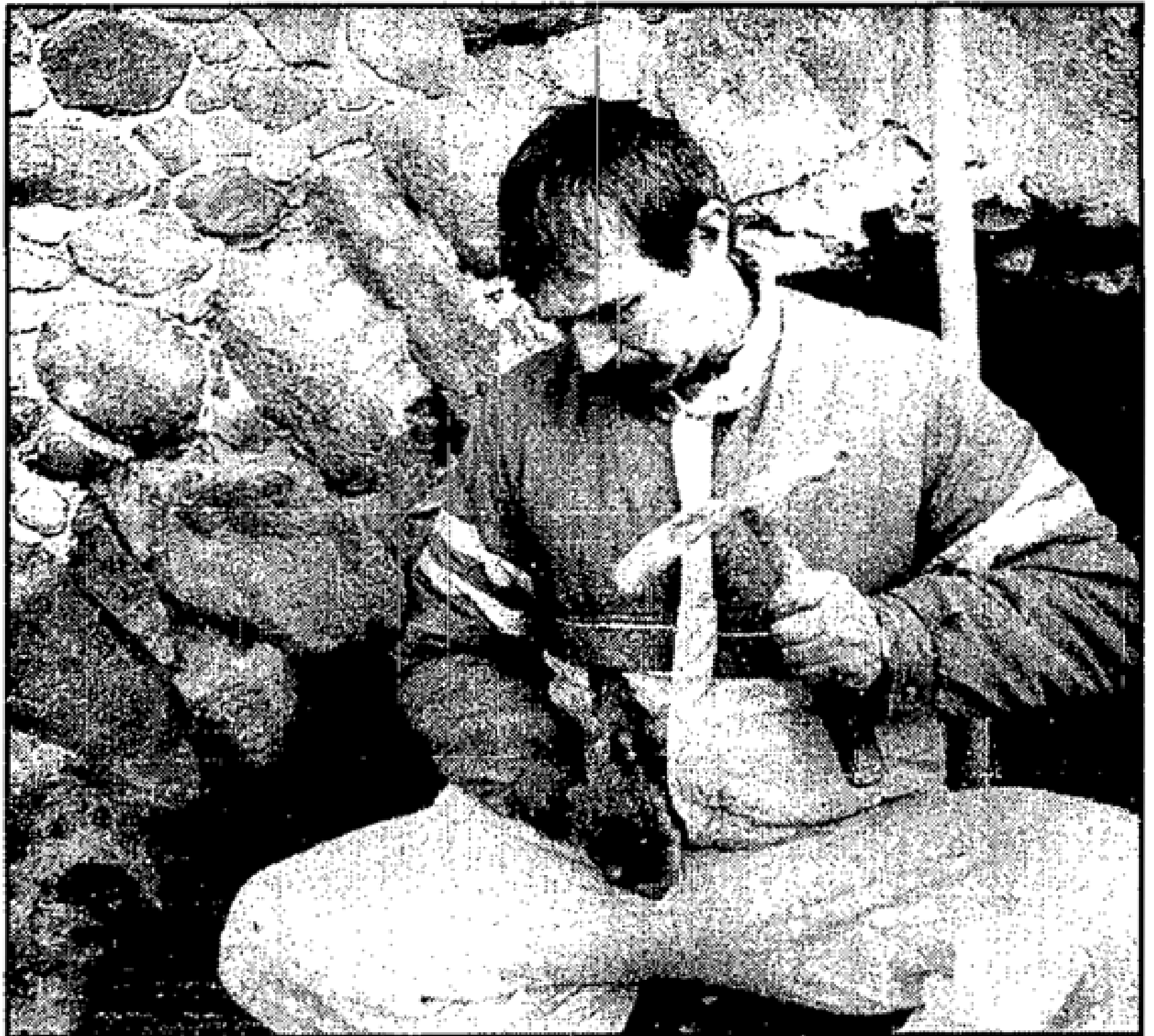
Die Steine werden behauen, um sie paßgerecht an der Außenmauer mit Mörtel einzufügen. Zement wird kaum verwendet.
