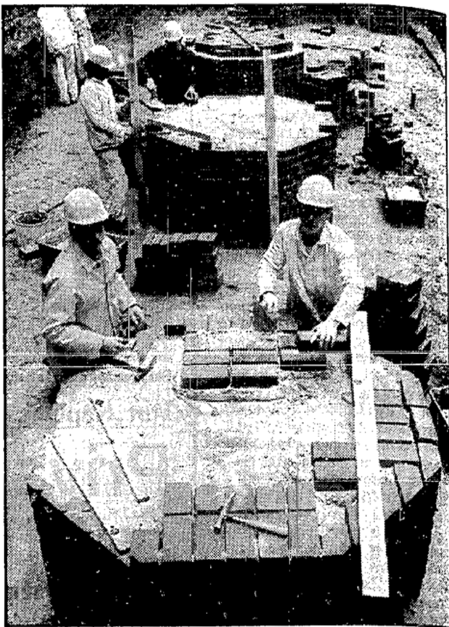
Mit Handstrich-Ziegeln und Spezialmörtel werden die Freipfeiler im Kirchenchor hochgemauert. MOZ-Fotos: Jur
