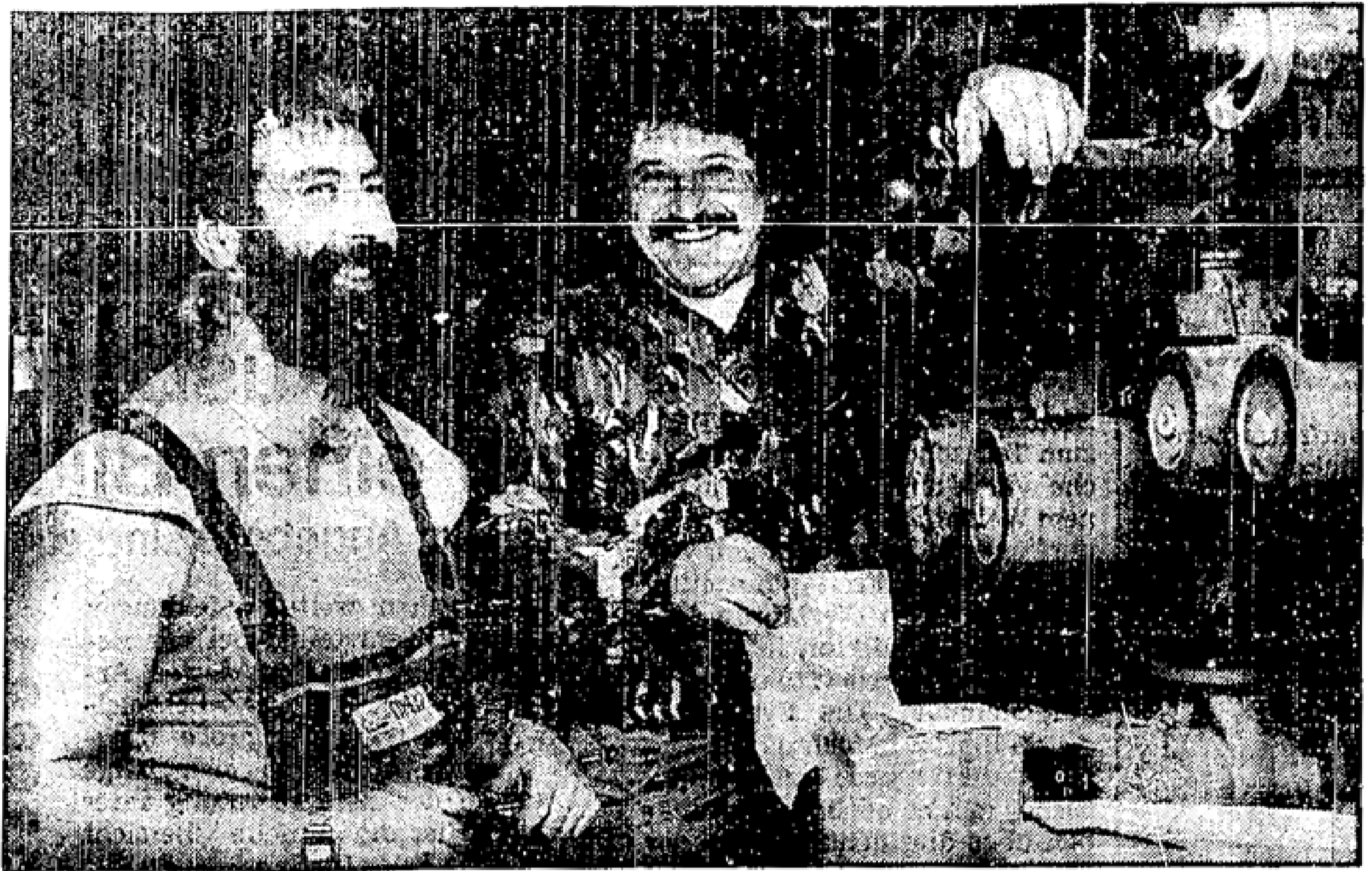
Monteur Jürgen Krüger (links) und Firmenchef Burkhard Opitz haben gut Lachen. Der Einbau der modernen Heizungsanlage im künftigen Beeskower Gymnasium geht gut voran. MOZ-Fotos: S. Jur
