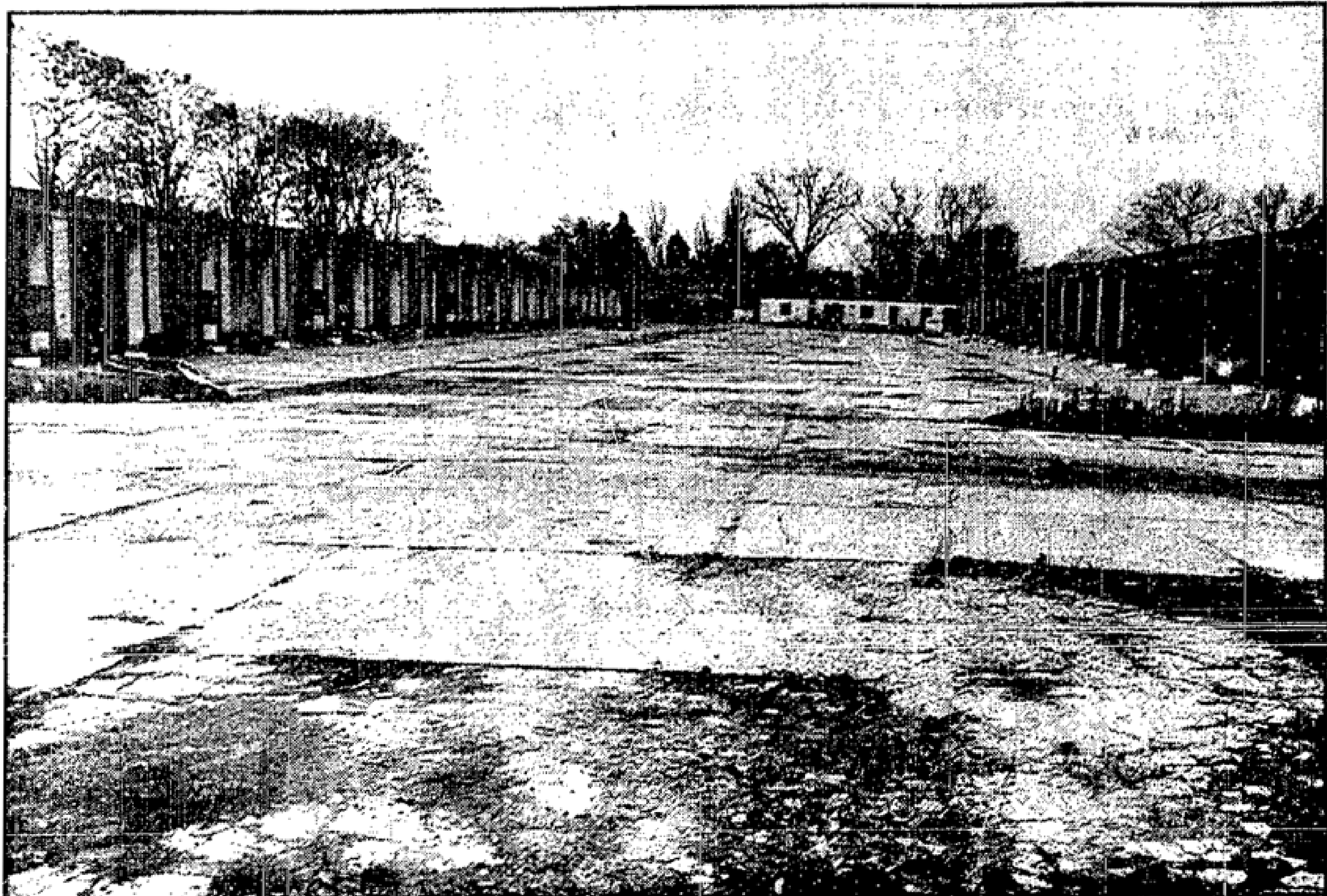
Jetzt können die alten Garagen auf dem Garnisonsgelände endlich weg, kann Platz für den Krankenhausneubau geschaffen werden. Im nächsten Jahr wird es den ersten Spatenstich geben. MOZ-Fotos: Jur
