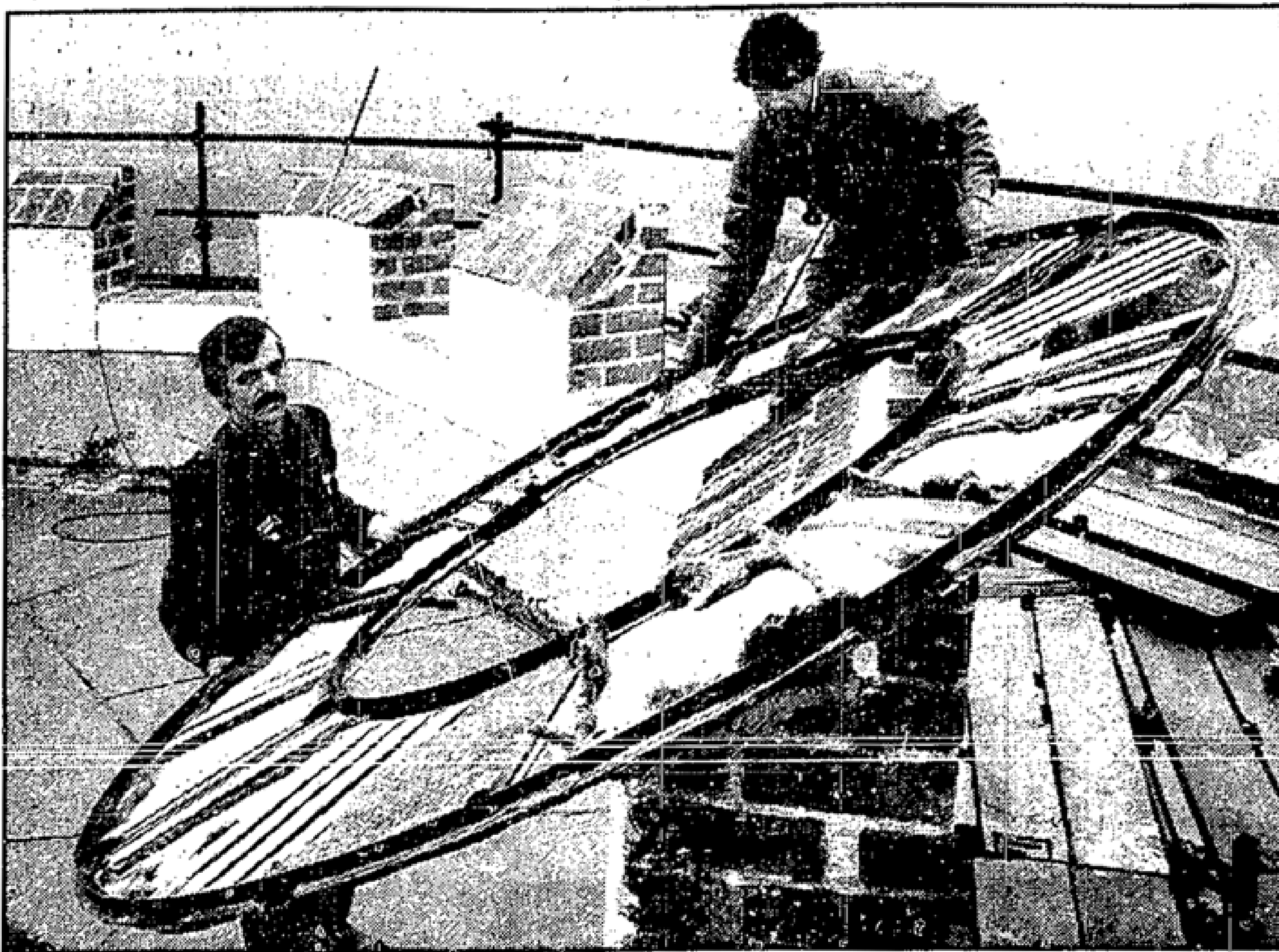
Karl-Heinz Schlodderer und Arndt Graupner bringen auf dem Turm von Sankt Marien das erste der drei 2,30 Meter großen Ziffernblätter an. Die Uhrenziffern allein sind 50 cm hoch.
