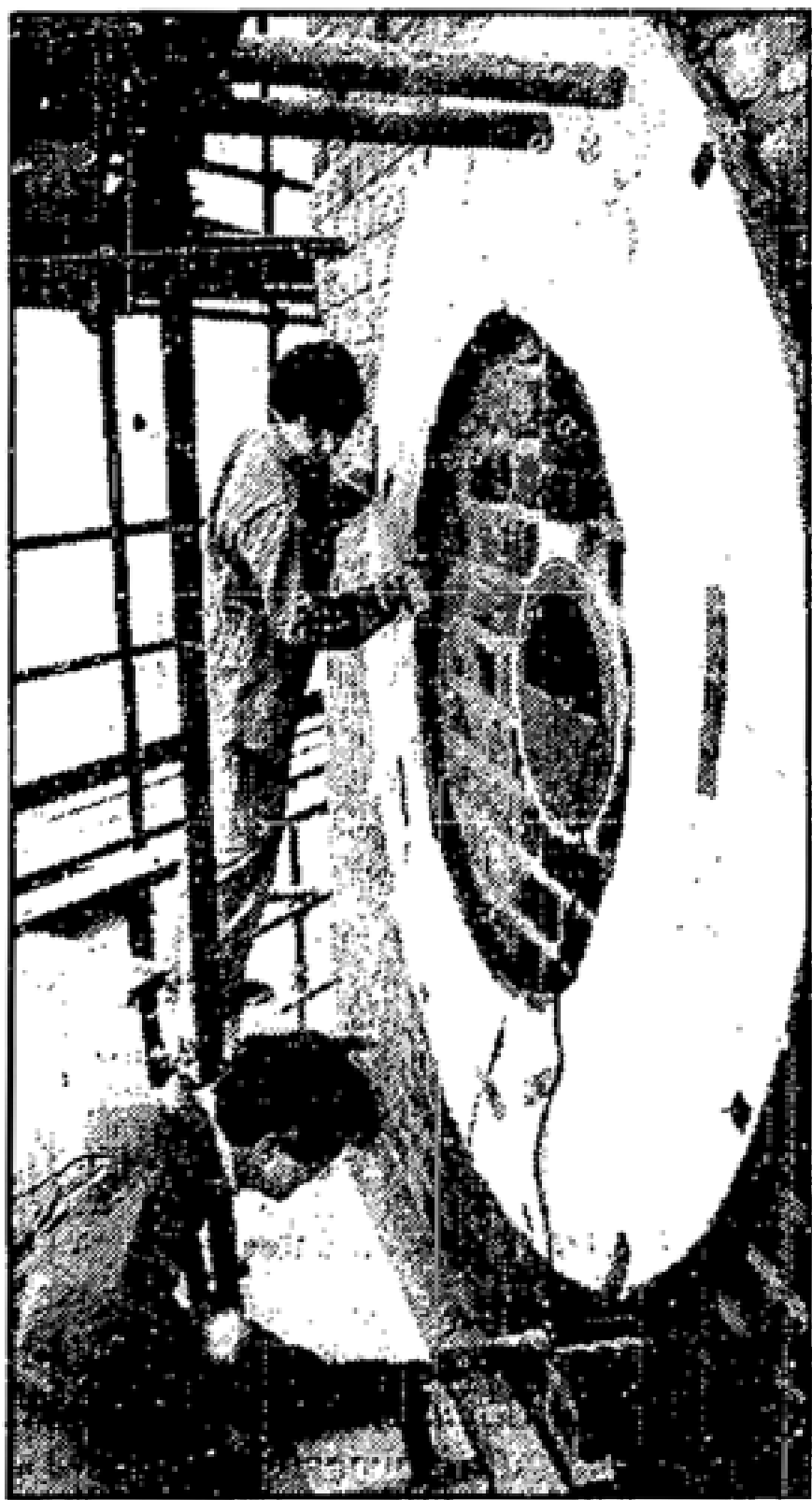
Die ausgepackten Ziffernblätter werden anmontiert.
