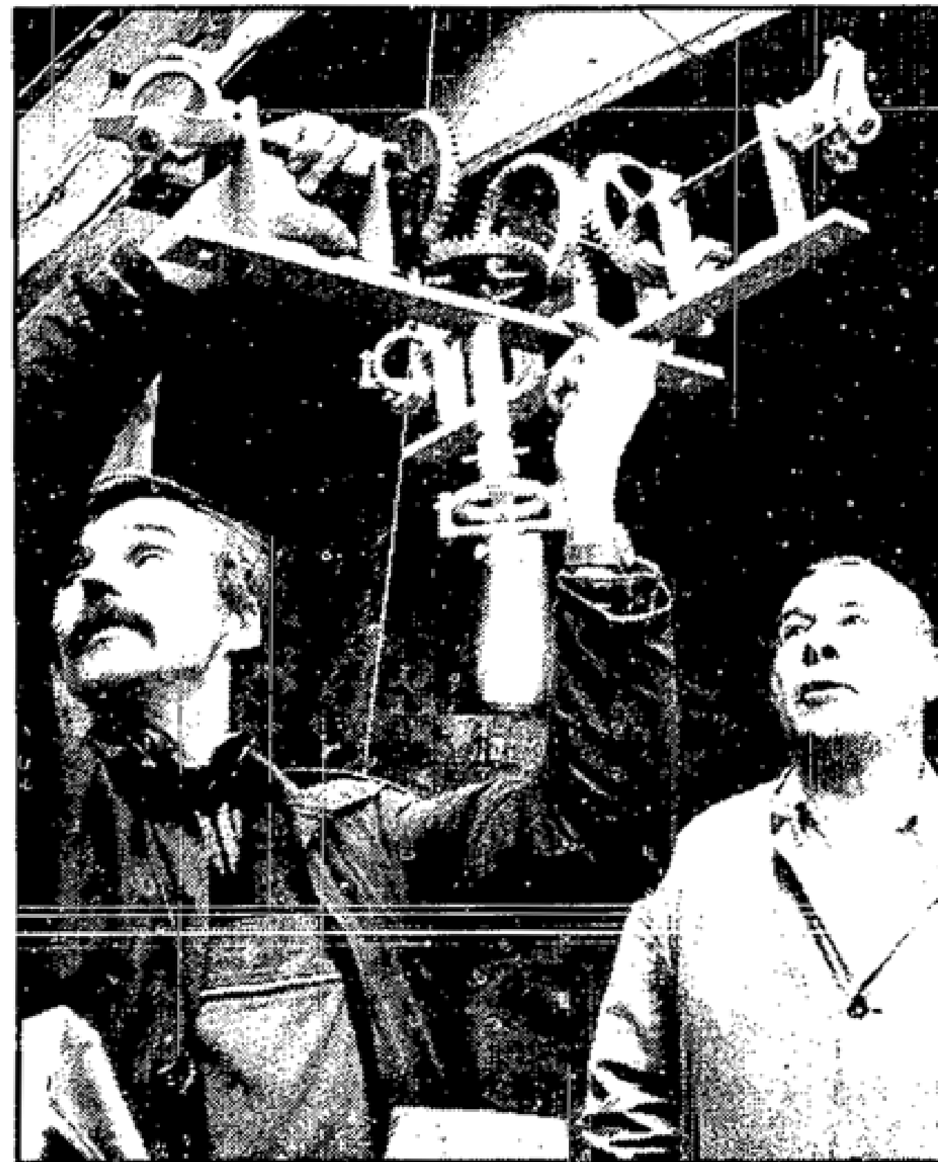
Gemeindepfarrer Eberhard Chors (r.) begutachtet das Winkelwerk, das die Kraft auf die drei Uhren überträgt.
