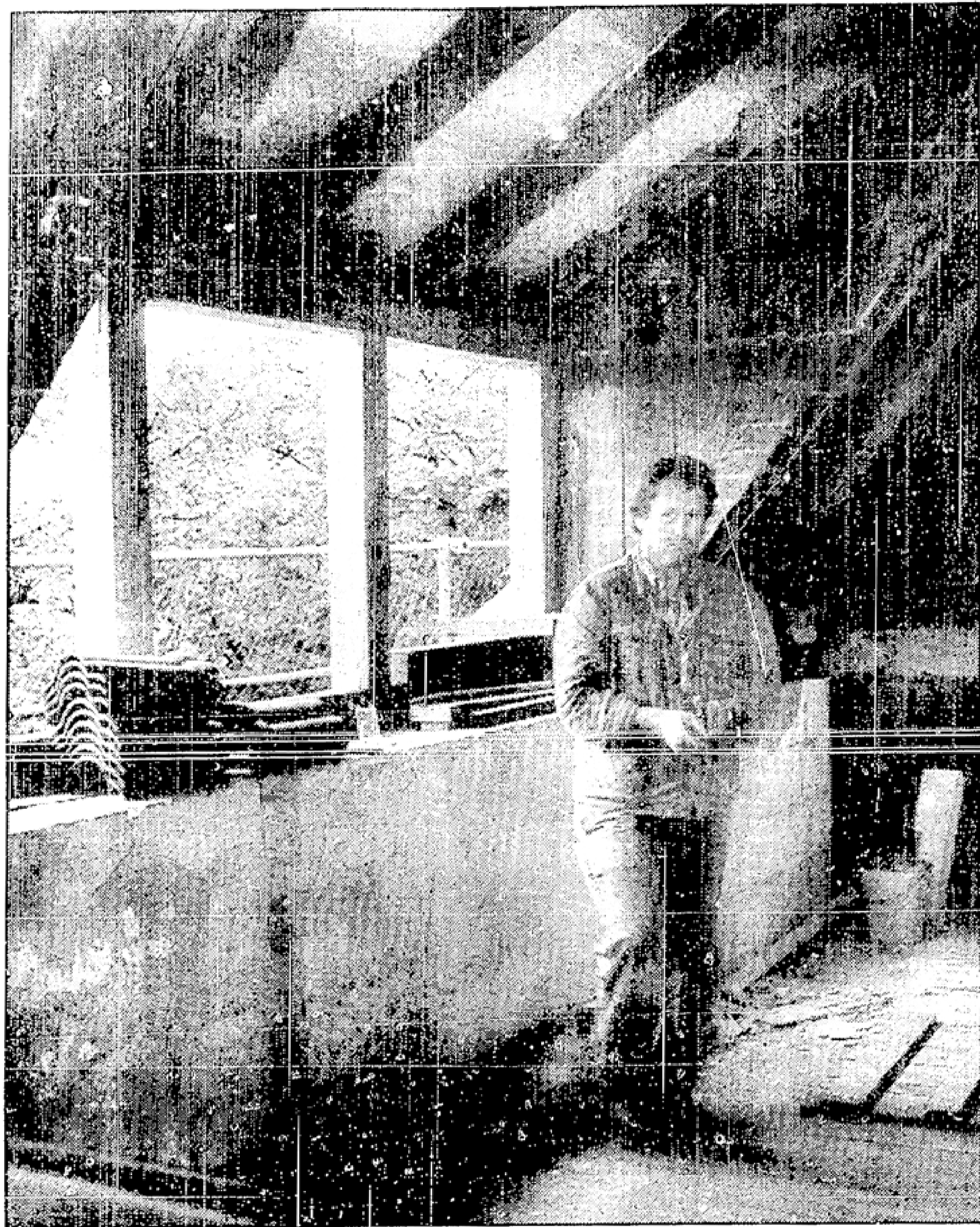
Mit dem Ausbau des Gutshauses in Beeskow zum „Märkischen Gutshaus“ ist die Firma Stoll aus Pieskow beauftragt. MOZ-Foto: Jur
