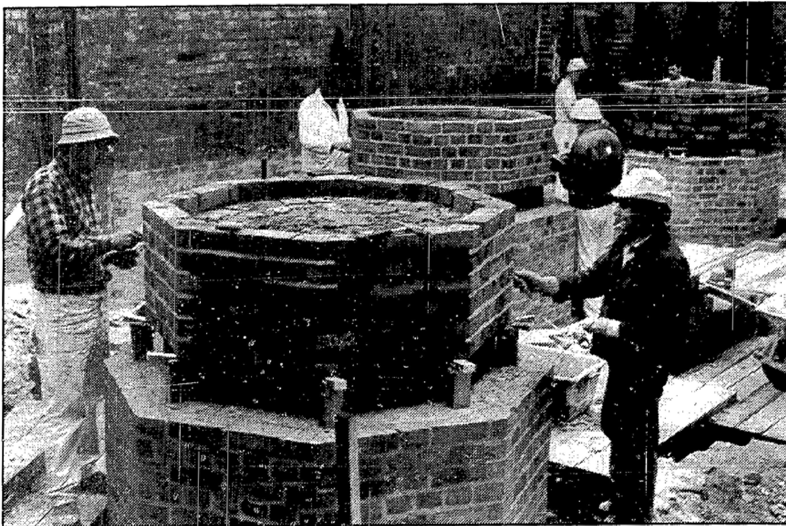
Zweiter Anlauf bei der Errichtung der sieben Chorpfeiler in der Beeskower St.-Marien-Kirche, nachdem zu früher Frost beim ersten Versuch das Abbinden des speziellen Mörtels verhindert hatte. Erst wenn die Pfeiler stehen, können die noch ausstehenden Arbeiten erledigt werden.
