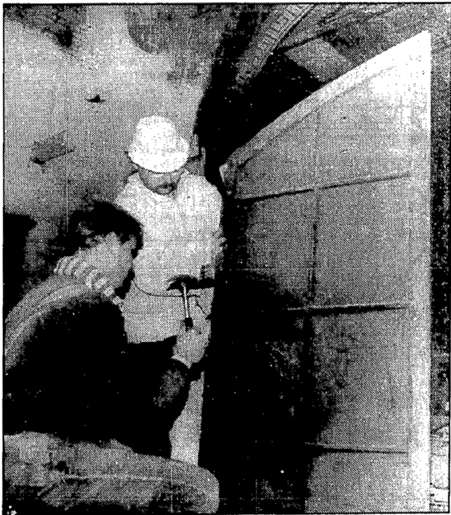
Das Schützenhaus wird umgebaut. Holger Vogel (links) und Rainer Hörnig von einem Frankfurter Baubetrieb bergen die oberen, bisher verdeckten Fensterflügel, um sie nach alten Maßen neu anzufertigen. Der große Saal des Beeskower Schützenhauses soll schon in wenigen Wochen in altem Glanz erstrahlen.
