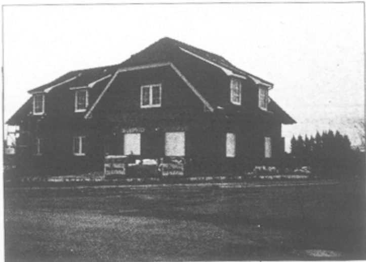
Das neue Bürogebäude im fast fertigen Zustand. So langsam kommt Leben ins Beeskower Gewerbegebiet "Charlottenhof".
