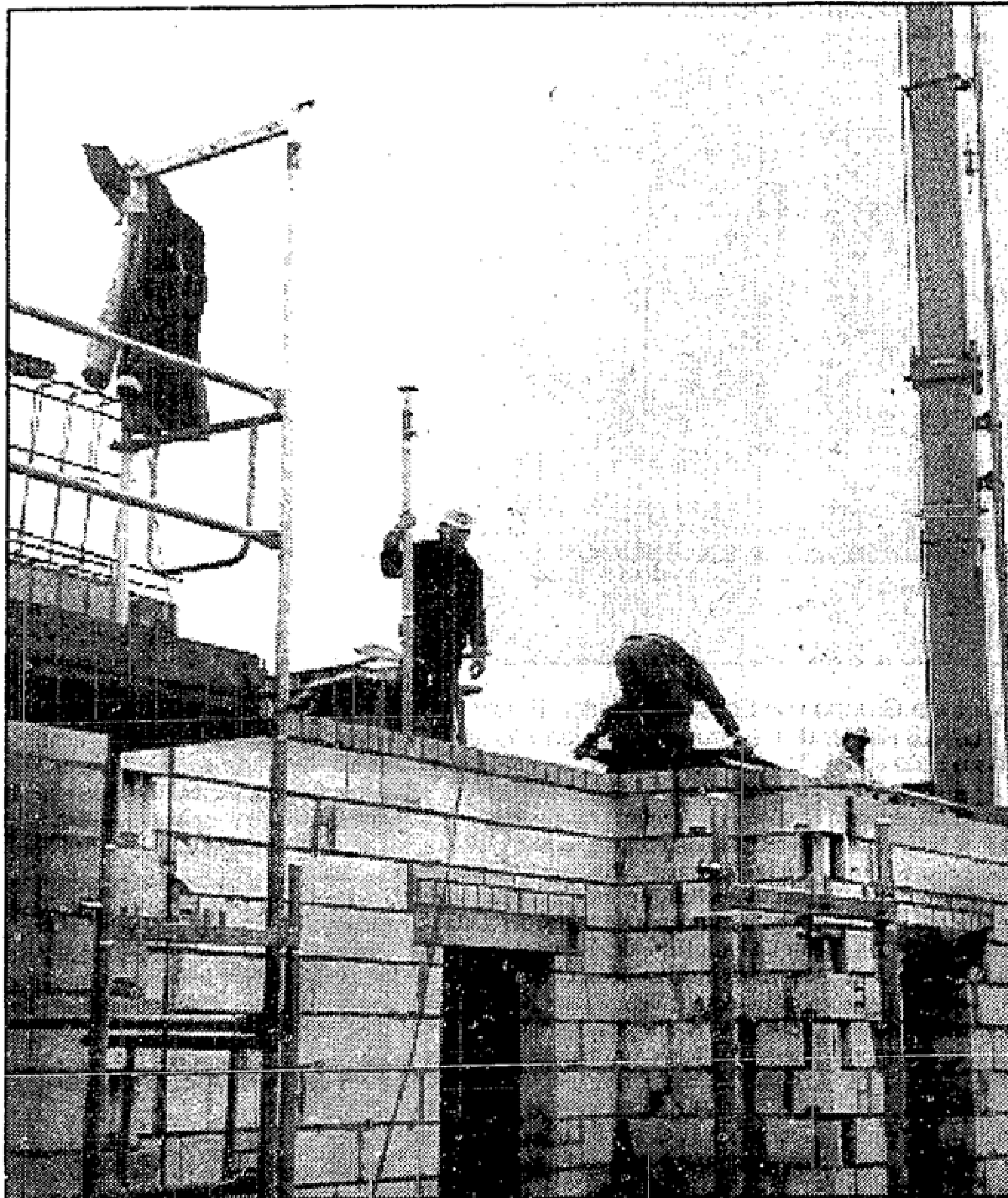
Zügig voran geht es am Markt 1 in Beeskow. Mit einem Kostenaufwand von 1,5 Millionen soll das Haus rekonstruiert werden. Von der Außenansicht her wird es sich im Prinzip nicht verändern. Hinter der Fassade jedoch entsteht ein neues Haus. Foto: Arendsee
