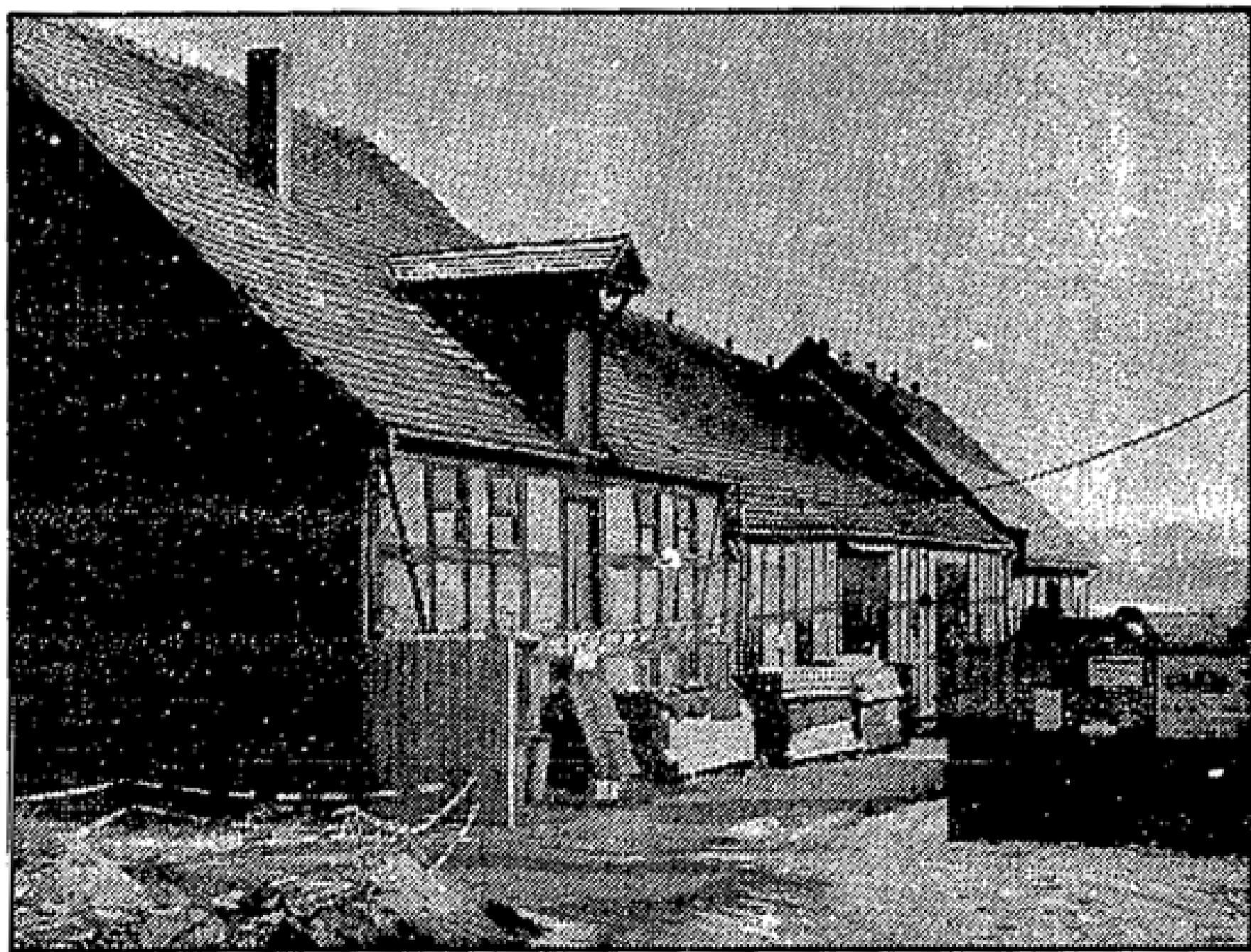
Die alte Scheune (links) zählt zu den schützenswerten Gebäuden Beeskows und ist – wie das ganze Spree-Gelände in der Gartenstraße – zu schade für einen Baumarkt.
